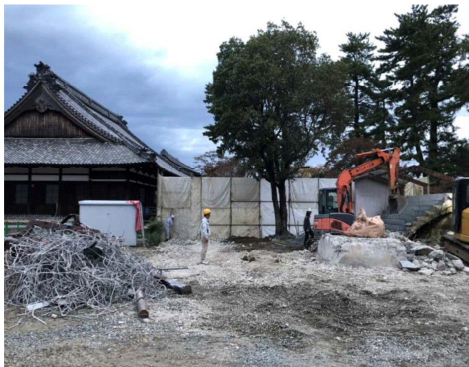
①水子地蔵堂解体
