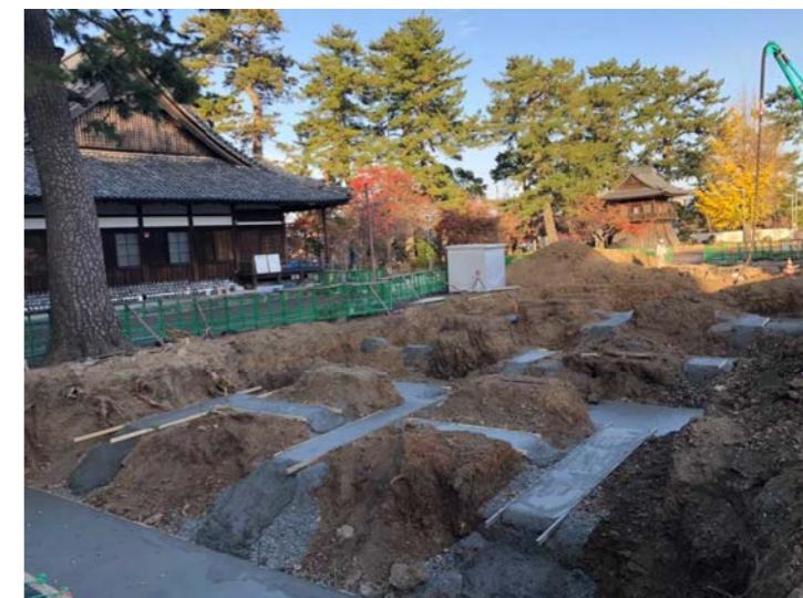
③基礎工事
