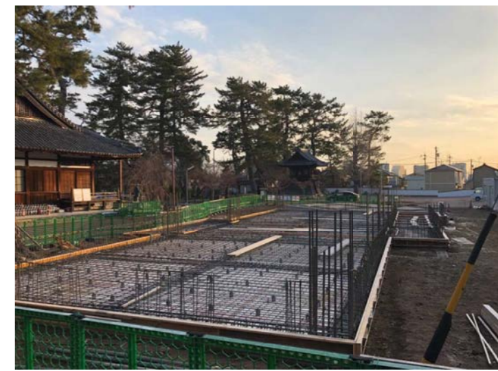
⑤土間型枠工事
