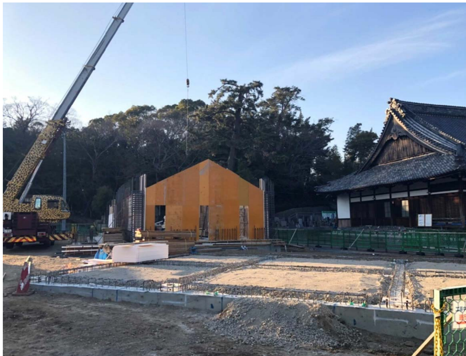
⑦納骨堂壁型枠設置
