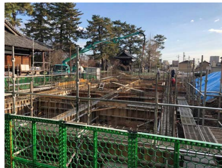
④基礎型枠コンクリート打設
