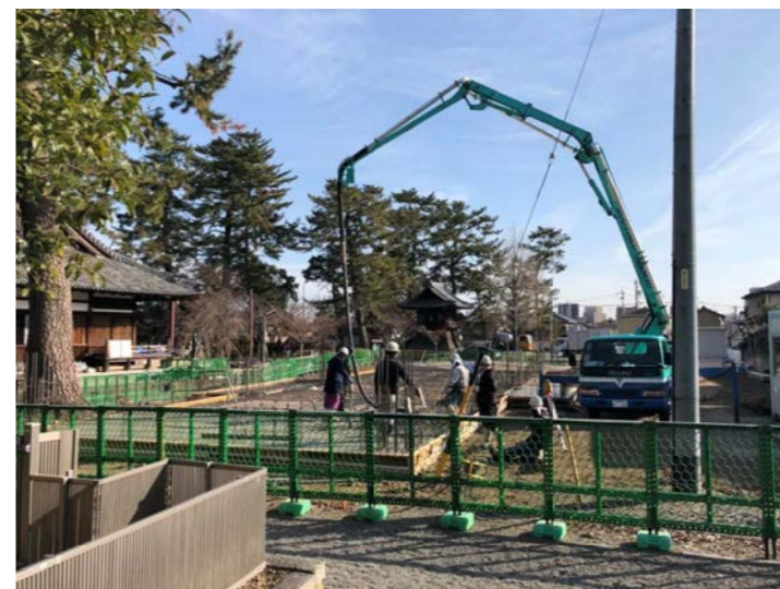
⑥土間コンクリート打設
